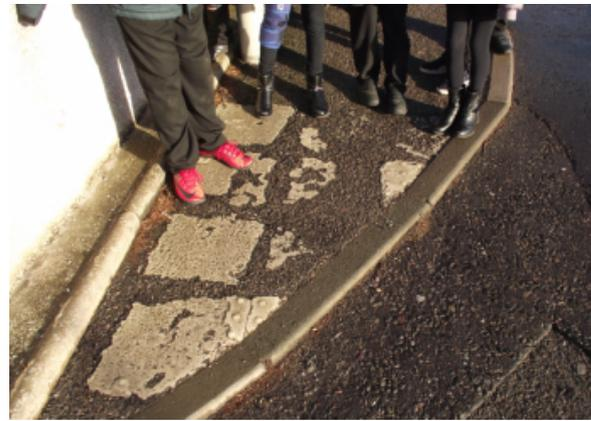
4. DISINTEGRATED EDGE MARKERS / UNEVEN SURFACE
