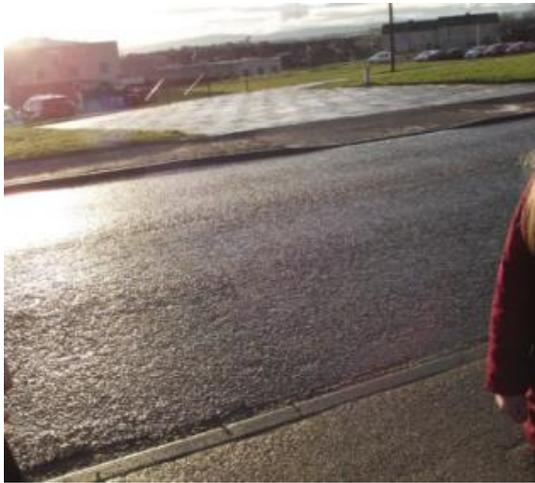
8. CROSSING PATROL POINT DROPPED KERBS ON COULARDBANK RD. MISALIGNED (DIAGONALLY)
